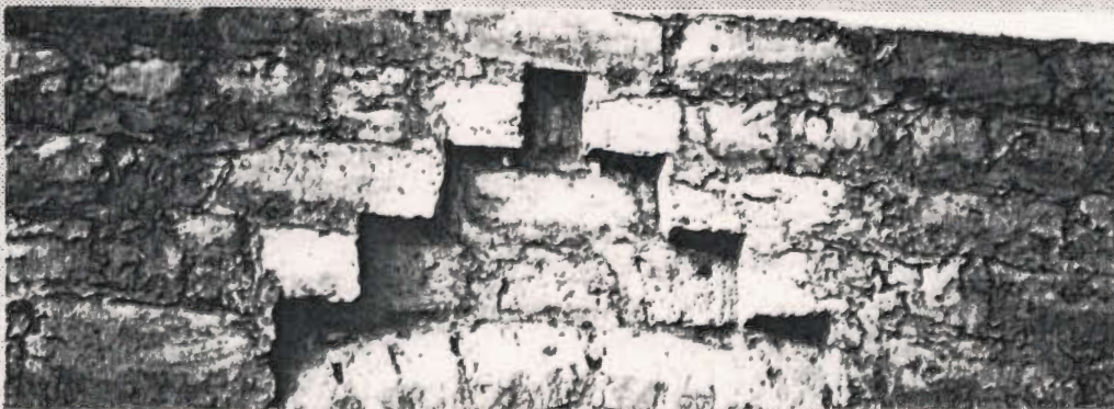
Décoration au dessus de la porte d'entrée - la maison de Mouloul Amoumoun à Tchirozerene.
