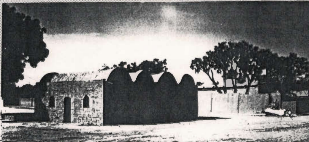
La mosquée de Bankoukou, conçue et construite par Mallam Abdou en 1990.
