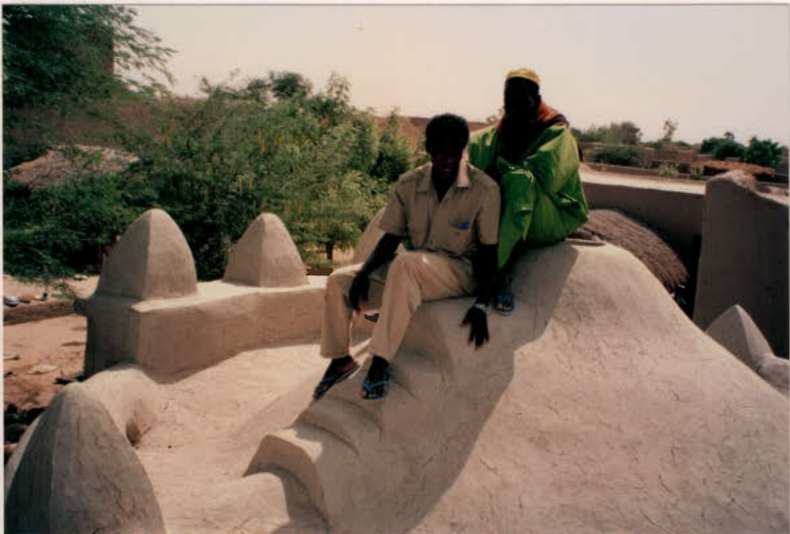
Atelier de forgeron à Wuro: marches expérimentales sur une coupole pour faciliter l'entretien
