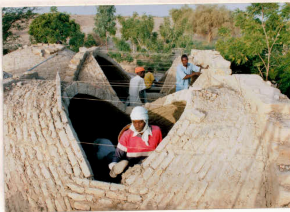
Construction des voûtes sur le bureau existant
