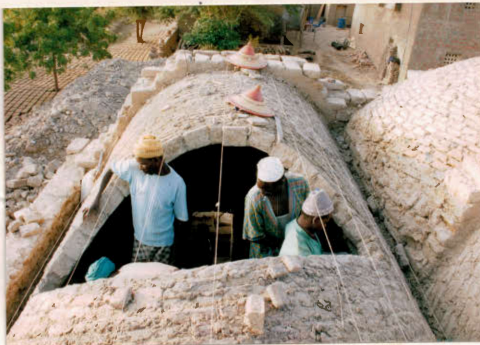
Construction des voûtes sur le bureau existant
