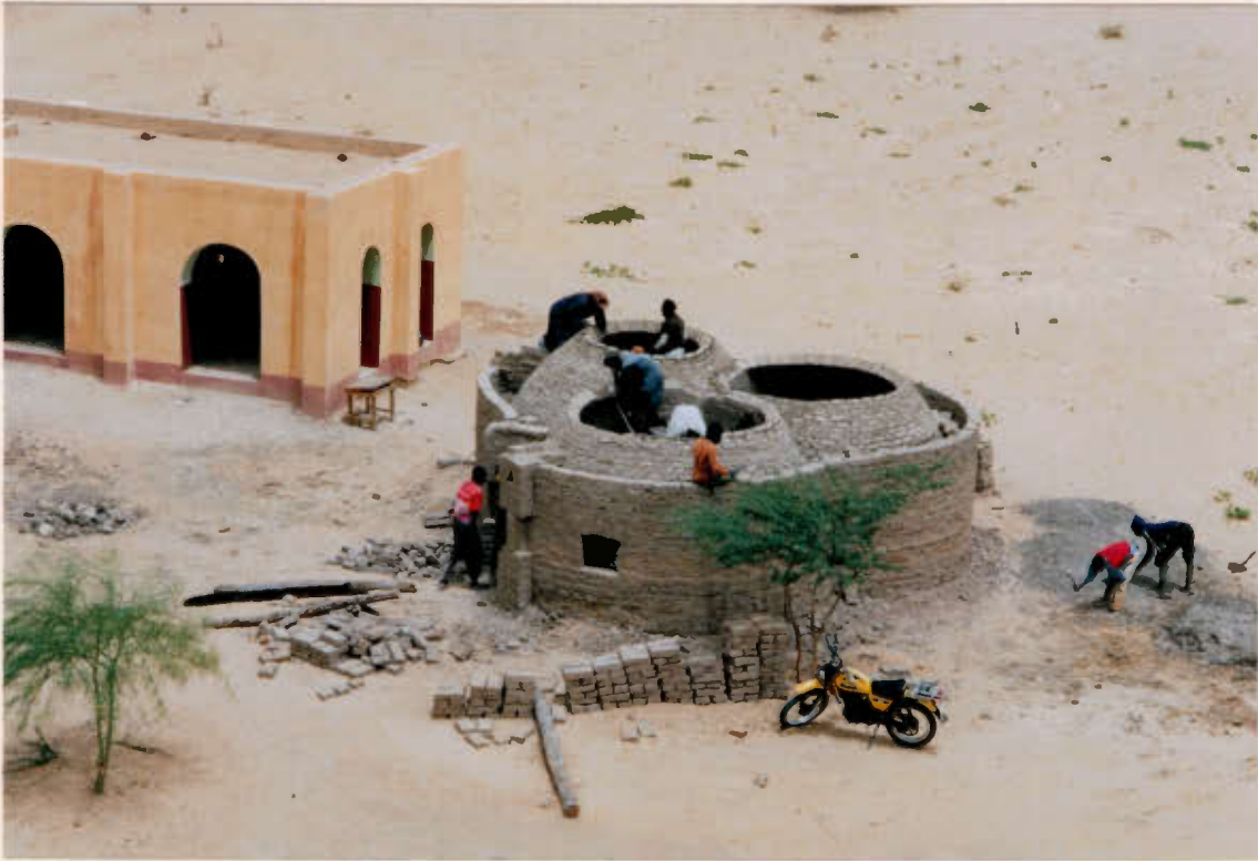
Logement de gardien au dispensaire: trois coupoles
