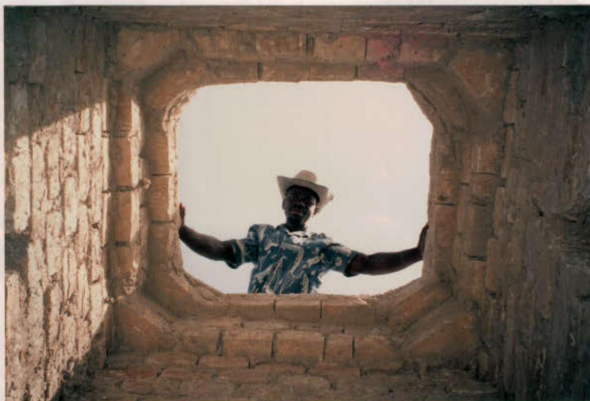
La cheminée centrale d'aération et d'illumination, nouveau bureau
