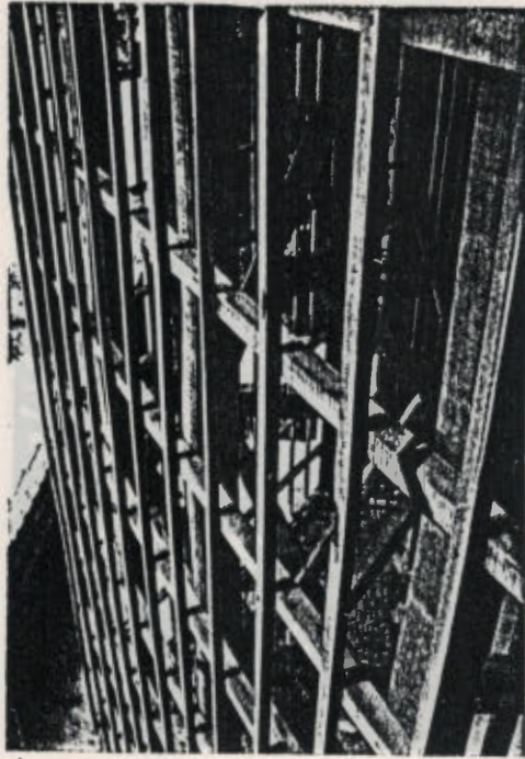
Hệ thống khung mái và giằng chéo Roof frame and diagonal bracing
