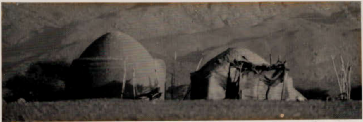
case ronde avec coupole, construite entièrement en terre crue non-stabilisée: sa forme rappelle celle de la tente (éhan) en matériaux végétaux...
