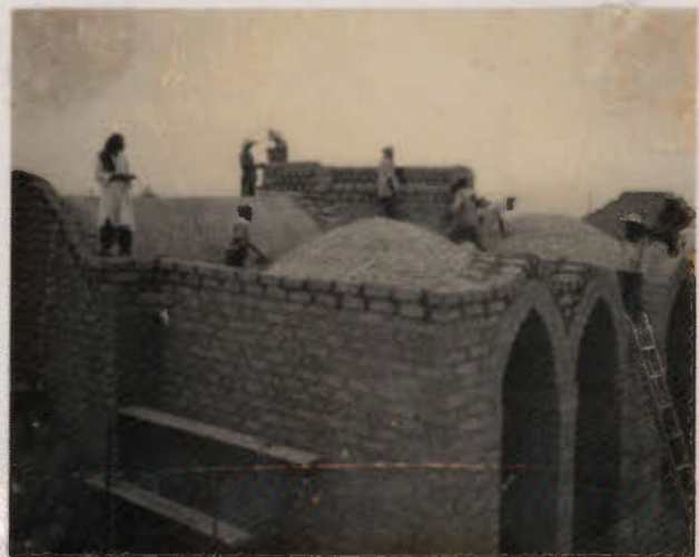
Un chantier bien suivi, un contrôle de qualité
