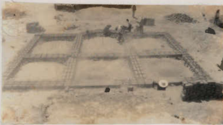
Un bon appareillage, sur de bonnes fondations...
