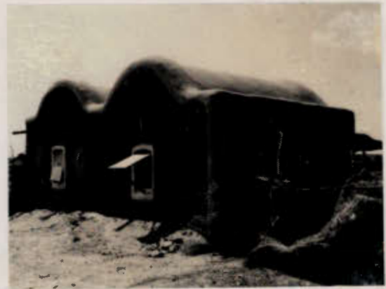
la qualité inférieure de la terre justifia ici l'utilisation d'un enduit semi-dur sur le toit et la façade est: 10 ans plus tard, l'enduit résiste bien...
