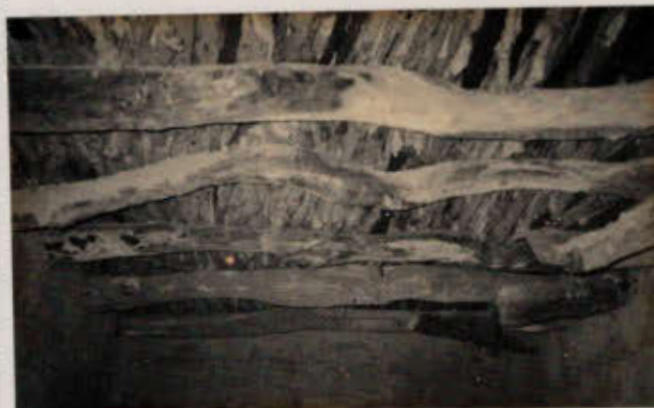
toiture plate typique de beaucoup de régions - utilisation massive de bois...
