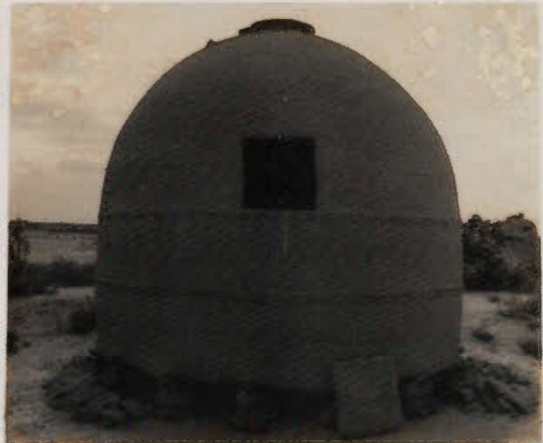
Grenier typique de beaucoup de régions du Sahel avec parois très minces en terre crue non-stabilisée. Le savoir-faire local existe pour qu'il résiste au climat...
