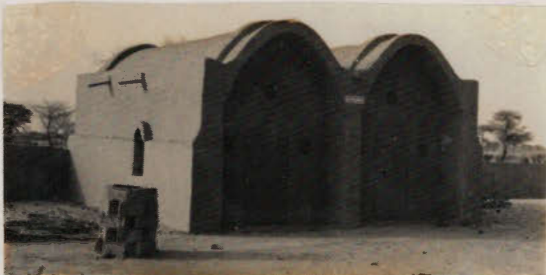
Avec un crépis en terre, et une bonne construction, ce bâtiment (Filingué, Niger) n'a demandé aucun entretien pendant 7 ans.
