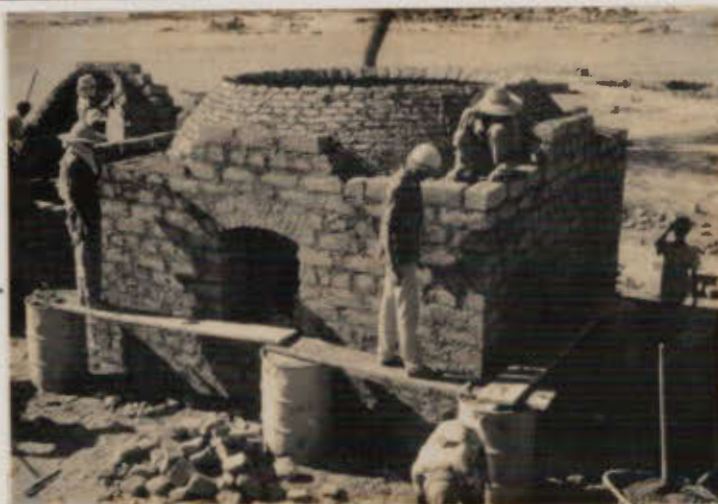
construction sans bois d'une coupole sur base rectangulaire (Niger) -
