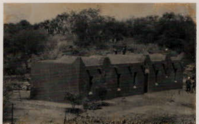
logements en voutes et coupôles (Mission Catholique, Tchirozerine)
