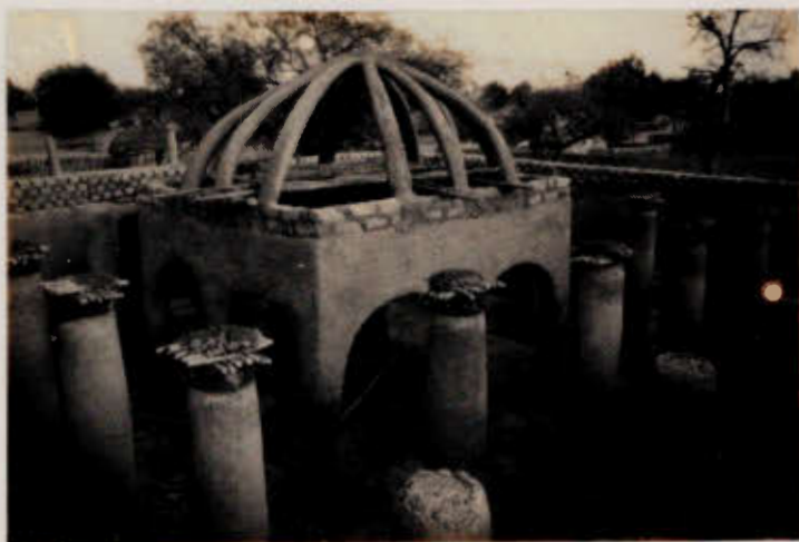
construction 'traditionnelle' d'une mosquée (Niger) -
