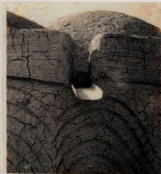
Une bonne évacuation des eaux de pluie, et un enduit qui convient....
