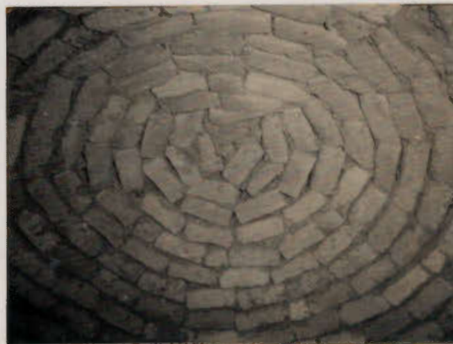
coupole en briques de terre crue non-stabilisée - aucune utilisation de bois, ni de coffrage...
