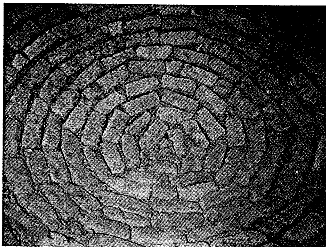
coupole en briques de terre crue non-stabilisée - aucune utilisation de bois...
