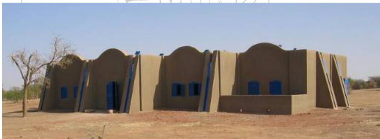
Musée Oursi Beero en construction sans bois, (terre crue, finitions de fabrication locale), Burkina Faso
