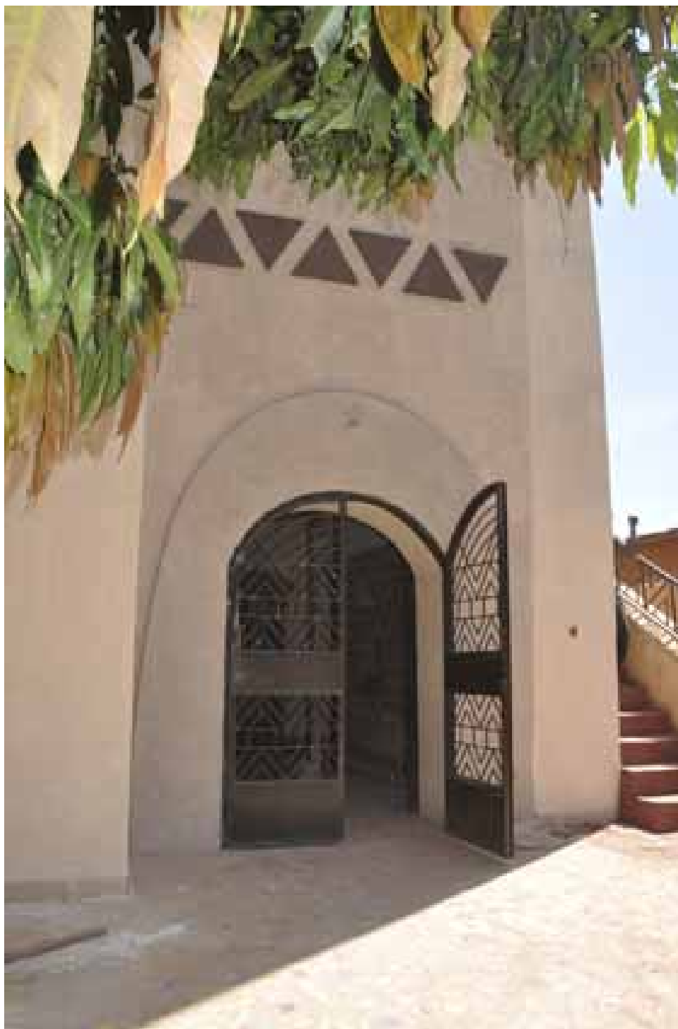
Maison privé en CSB à Bobo Dialoussou, conception DWF, réalisation pour un GIE de maçons de Bougé, Soum
