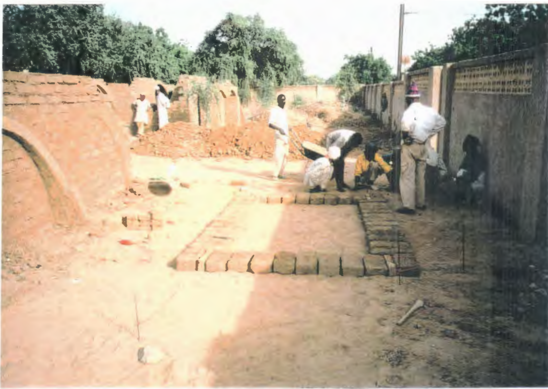
Implantation d'un rectangle en utilisant des briques pour en déterminer les dimensions
