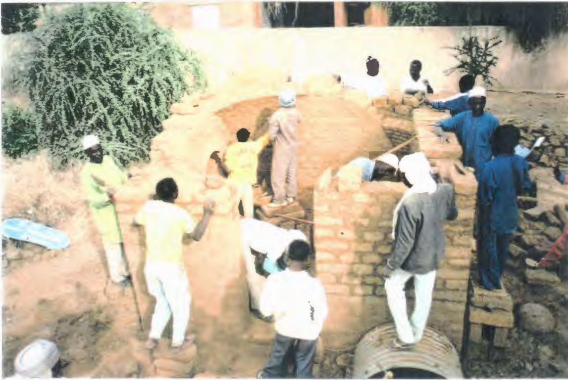
Monter l'extérieur des coins
