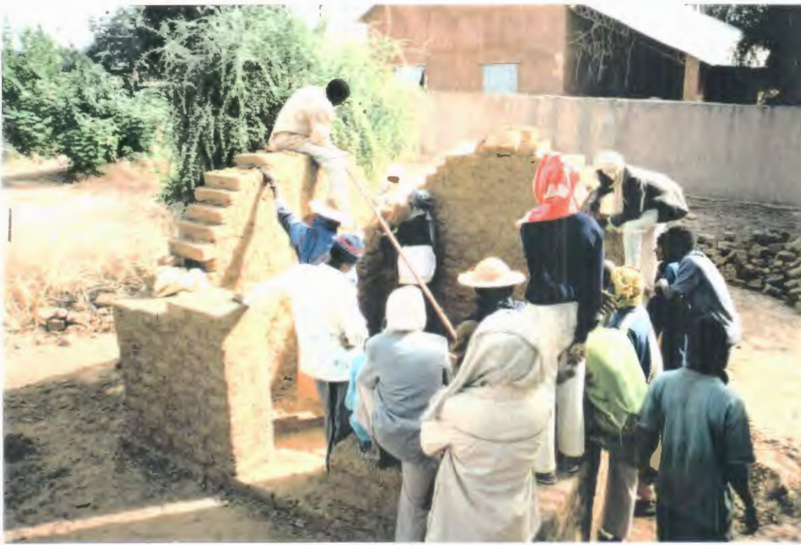
Construction et forme des murs sommiers
