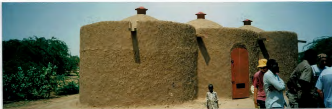
L'une des 2 banques céréalières construites par PROFORMAR à la sortie de Tahoua
