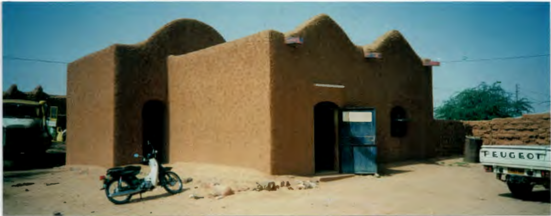
le magasin de stockage et son extension
