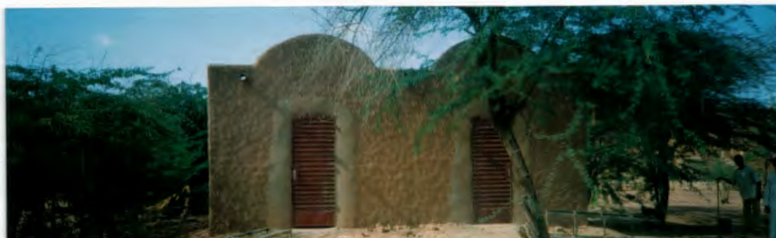
Un petit bâtiment voûté construit sur le terrain de la Mairie. L'une des pièces sera le bureau de l'Association des maçons CSB.
