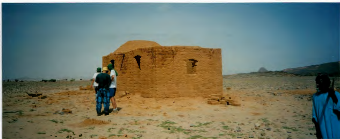
magasin de la coopérative en construction à quelques kilomètre d'Iférouane
