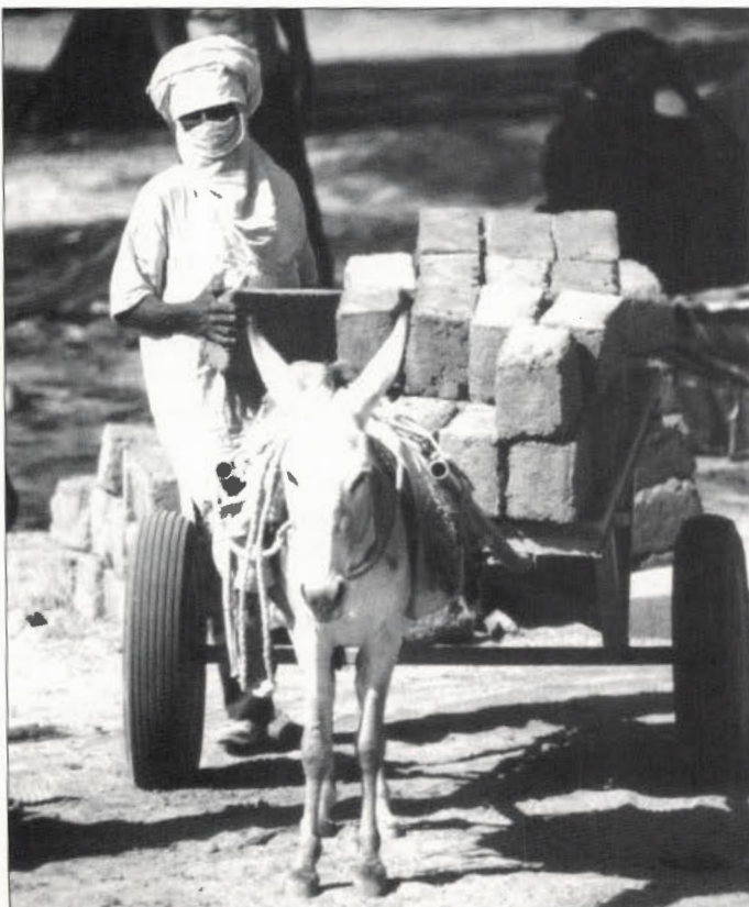
Figure 1 Briques faites à l'aide d'un simple moule en bois, séchées au soleil
