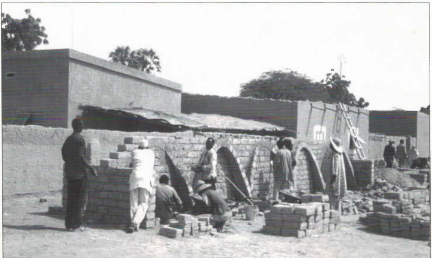
Figure 1 Maçons stagiaires s'exerçant au démarrage des voûtes sur des structures de formation (phase 2)
