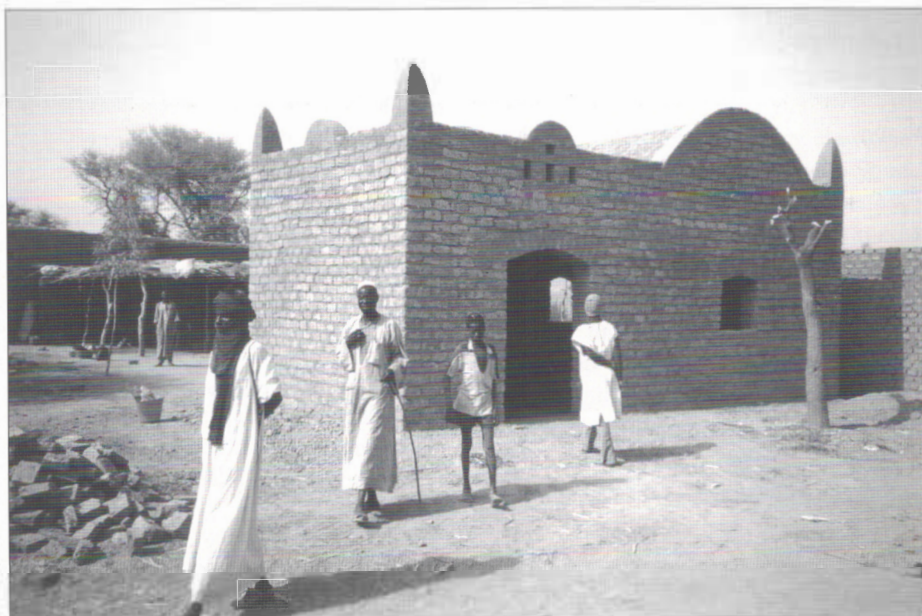
Figure 4 Chaque bâtiment commandité par un client partenaire fournit aux maçons stagiaires la possibilité de réaliser un bâtiment complet (phase 3)
