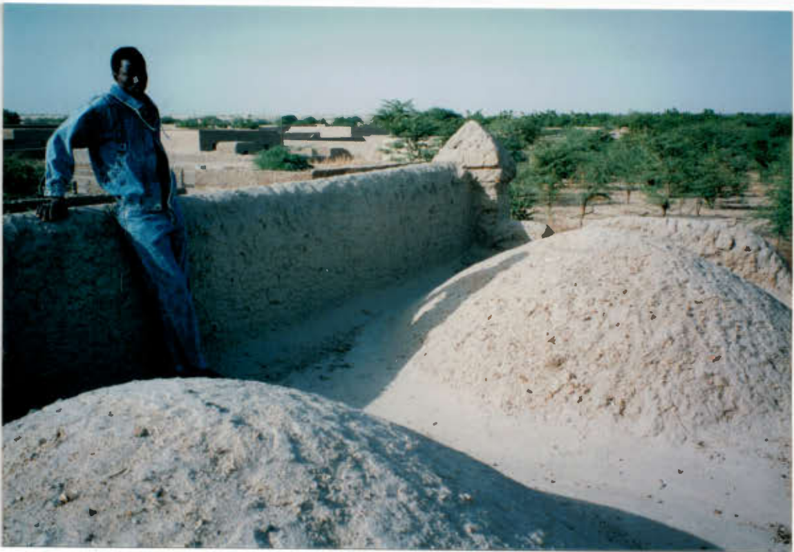
En générale, bonne performance des toitures CSB, malgré une saison des pluies éprouvante...
